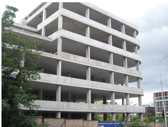
Obr. 6 Objekt se svislými nosnými sloupy
