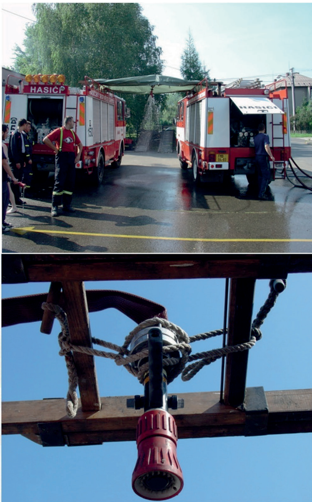
Obr. 46 Improvizované stanoviště dekontaminace techniky
