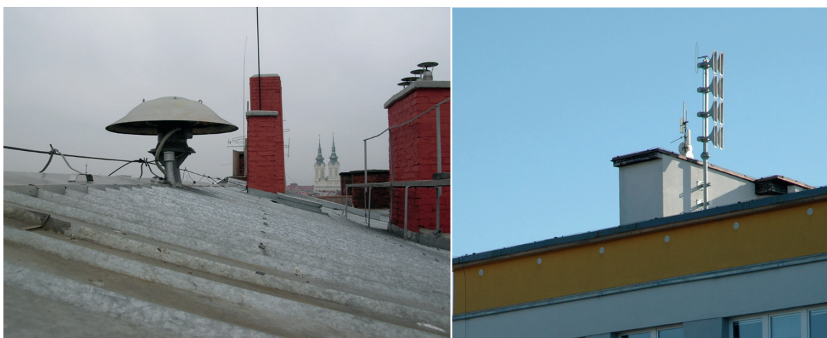
Obr. 32 Rotační a elektronická siréna (vlevo ROT typ DS 977 3,5 kW, vpravo ENS typ MAESTRO 1000W)
